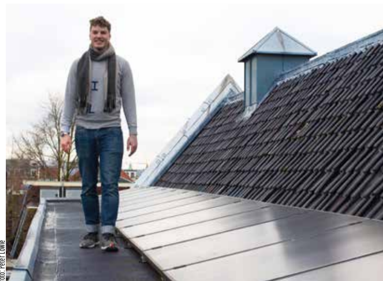
Daniël van Duijn op het dak van de Keizersgrachtkerk met de zonnepanelen.
